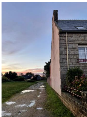
Façade en pierre de la maison attenante à la venelle – ©Territoire+
